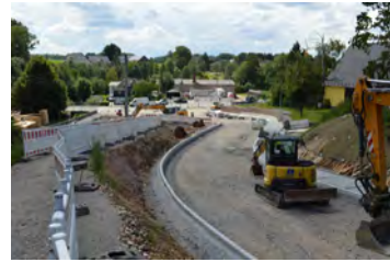
Großbaustelle an der Wolfsschlucht im Ortsteil Langenchursdorf
