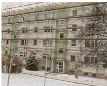
Sanierung der 104-WE-Anlage an der Altenburger Straße im OT Callenberg
