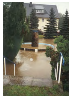
Hochwasser 2002 auf dem Springbrunnengelände in Langenchursdorf
