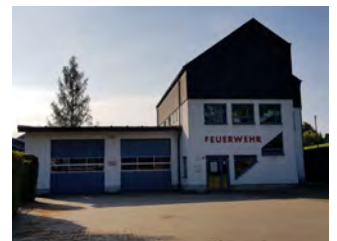
neu erbautes FFW-Gebäude in Langenchursdorf
