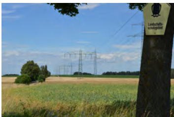
zwei parallele Trassen für Höchstspannungsleitungen im Landschaftsschutzgebiet „Mulden- und Chemnitztal, hier in der Gemarkung Langenchursdorf
