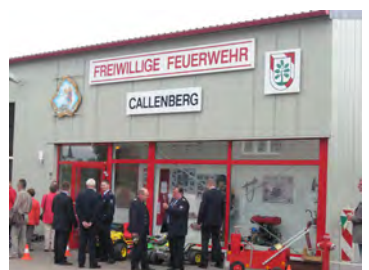
neues FFW-Gerätehaus Callenberg
