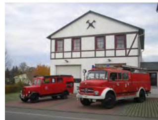
neu erbautes FFW-Gebäude in Grumbach
