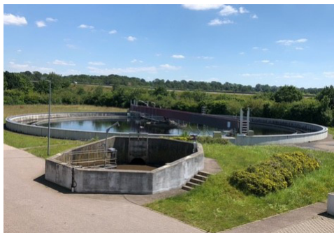
Das Nachklärbecken (Bild: WAD GmbH)
